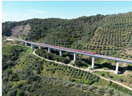
Viaducto de Churroteles. Tramo Córdoba Puertollano
